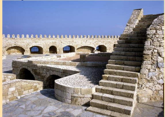
Το δώμα του φρουρίου με μεταγενέστερες επεμβάσεις
