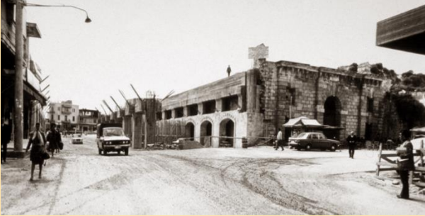
Η Καινούρια Πόρτα πριν τη γεφύρωση του ρήγματος
