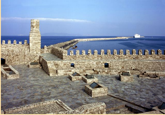
Τμήμα από το δώμα του Κούλε, όπου διακρίνονται οι επάλξεις και οι κανονιοθυρίδες
