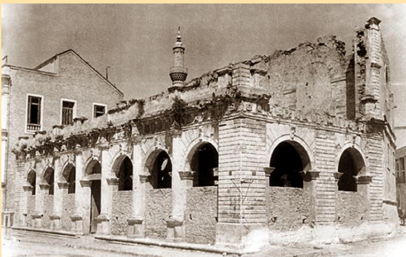
Η ενετική Λότζια, κατά τη διάρκεια της κατεδάφισης του α' ορόφου, G. Gerola, 1904
