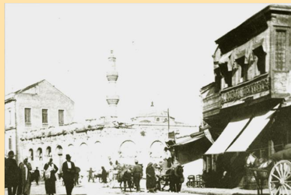
Η Λότζια μετά την κατεδάφιση του α' ορόφου, στις αρχές του 20ού αι.
